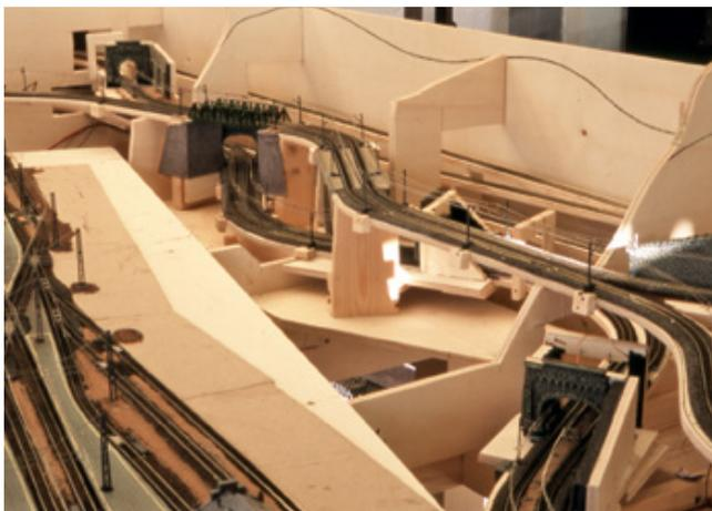
Die Anlagenblenden werden zunächst provisorisch am Grundrahmen befestigt und an den Oberkanten wird das Geländeprofil angezeichnet.
