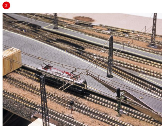
Die zu verlötenden Fahrdrähte werden gleismittig am Tragwerk mit einer Kreuzpinzette in Position gehalten. Eine alte E-Lock dient als wertvolle Justierlehre.
