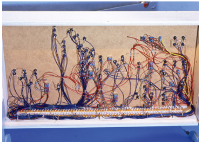
Besondere Sorgfalt ist beim Verlegen der Kabel erforderlich. Die Aufnahme zeigt, dass der ursprüngliche Kabelwald schon ziemlich ausgeleitet ist.
