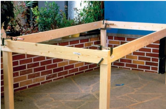
Die „**Geburt**“ des Grundrahmens beginnt mit den vier Außenrahmenteilen und den vier Eckstandbeinen, die vorerst in der richtigen Position mit Schraubzwingen festgehalten werden. Erst wenn der Rahmen waagrecht steht, kann er verschraubt werden.
