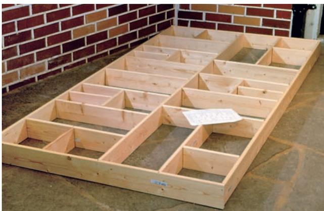
Zur **Prüfung der Passgenauigkeit** werden die genau abgelängten Streben lose zum fertigen Rahmen zusammengestellt. Etwaige Fehler können in diesem Stadium noch relativ problemlos behoben werden.
