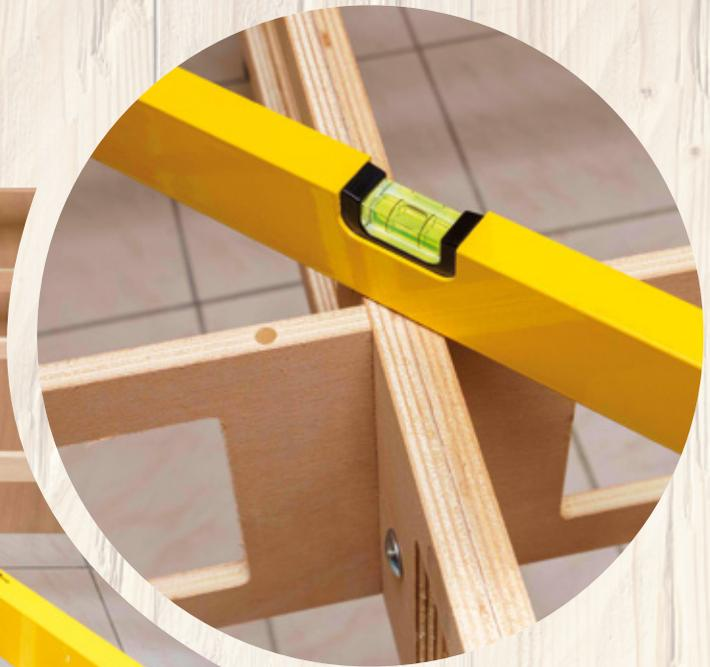
Nicht vergessen: Der Grundrahmen sollte völlig eben stehen. Wir nivellieren ihn deshalb mit einer langen Wasserwaage – gut, dass unsere Tischbeine höhenverstellbar sind.
