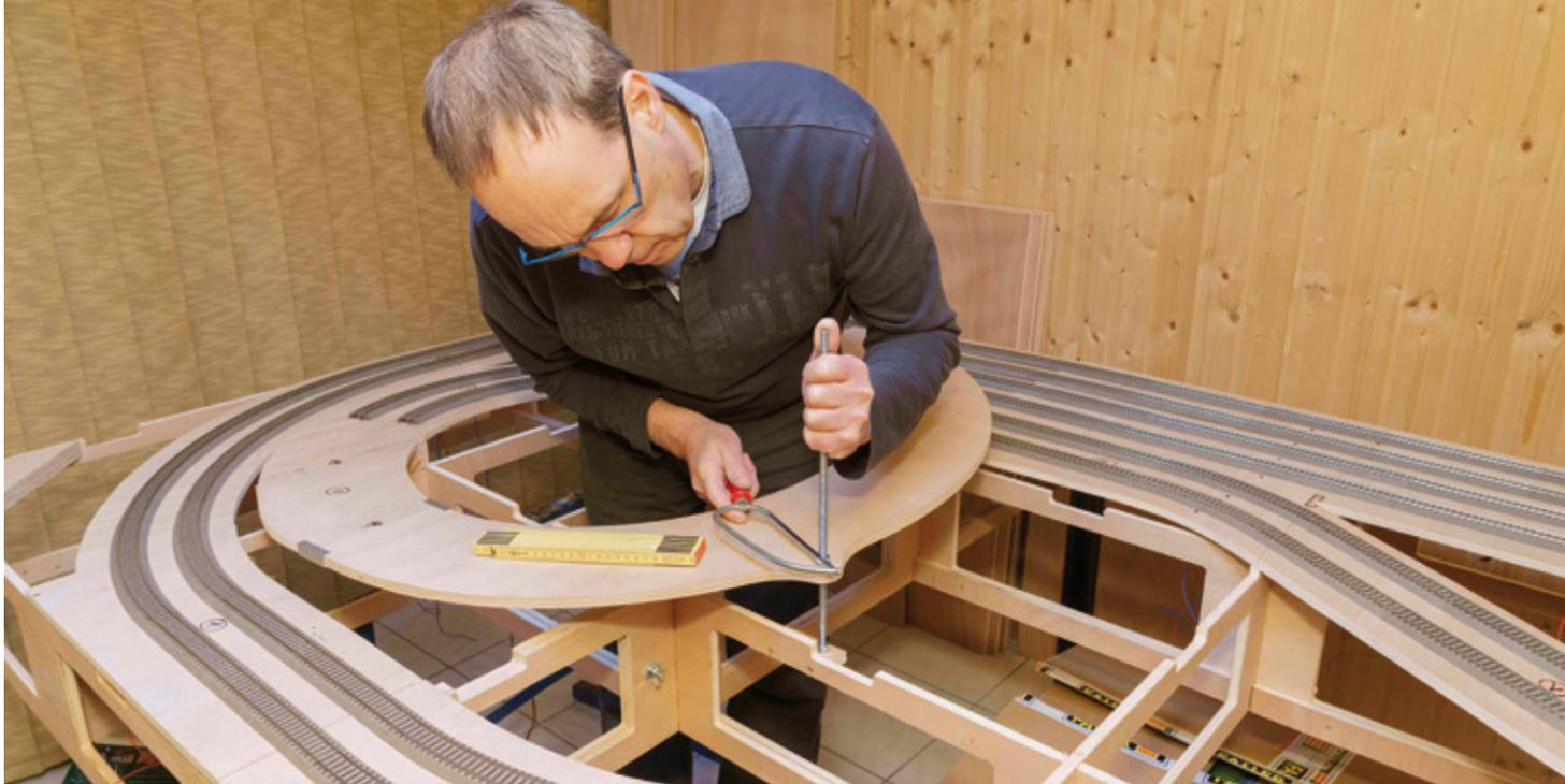
→ Nachdem nun Stück für Stück die Schienen für den pro Richtungsgleis zweigleisigen Schattenbahnhof verlegt wurden, fixieren wir diese immer wieder mit den Gleisschrauben. Zudem übertragen wir vom Gleisplan nun noch die jeweiligen Gleishöhen in einem angemessenen Abstand auf diese Trassen. Dies ist hilfreich für das spätere Übertragen auf die Spanten.
