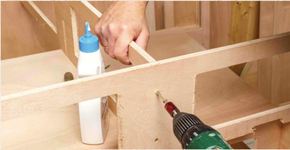
Die Querspannten befestigen wir an den Außenspannten mit Spaxschrauben 4x40.
