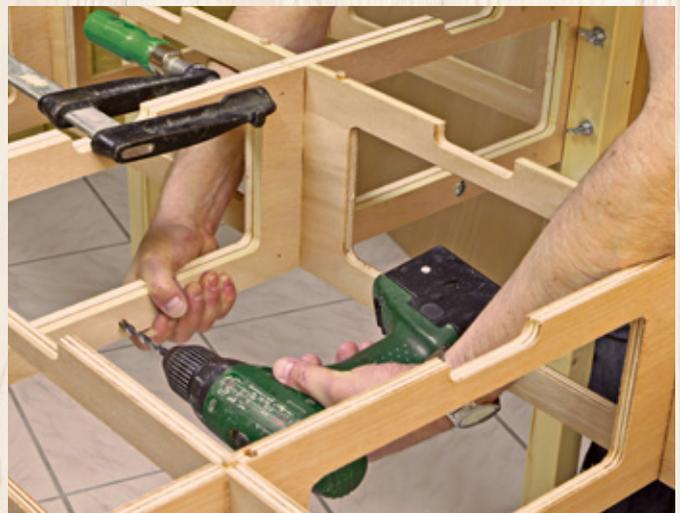
Beim Bohren biegt sich das flache und flexible Sperrholz des Rahmens manchmal etwas durch. Tipp: Wenn man die Hand etwas dagegendrückt, wird das Bohren leichter und die Löcher sitzen absolut exakt.
