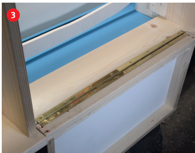
Damit ein einwandfreier Schwenklauf sichergestellt ist, schrauben wir den Pultrahmen zur Probe schon einmal an Ort und Stelle am vorgesehenen Platz im Anlagenrahmen fest.
