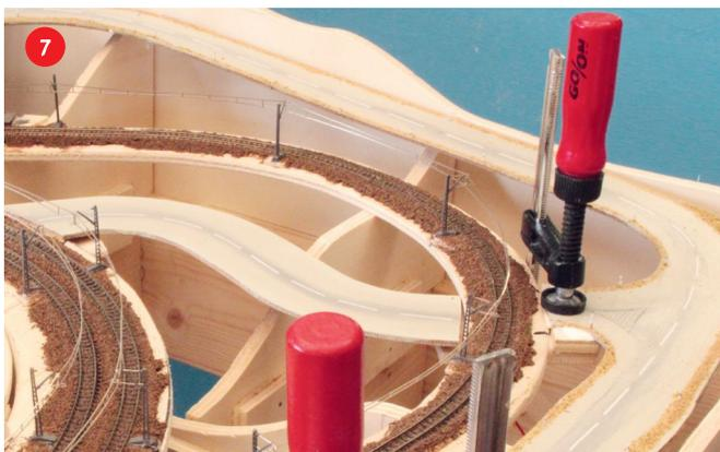
**Die fertigen Straßenzüge werden an vorgesehener Stelle mit Weißleim und 25er-Nägeln fixiert. Bis zum Aushärten des Leims halten leichte Schraubzwingen die Trassen in Position.**
